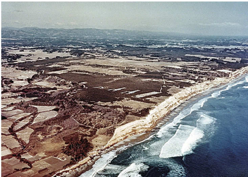
P1-1 福島第一原発の建設用地 (撮影年不明) FDNPS construction site (shooting year unknown)
