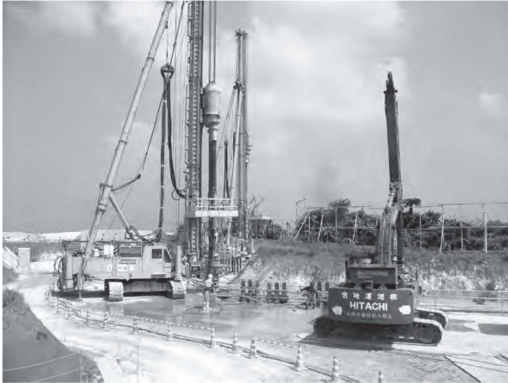
地下ダム工事写真
