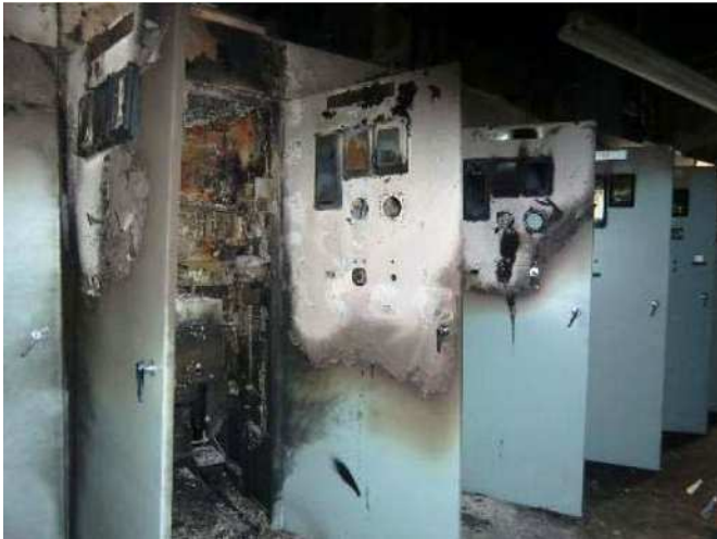
焼損した女川原発1号機の配電盤<写真 左>=東北電力の公開資料=
